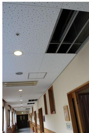
廊下の天井パネル
